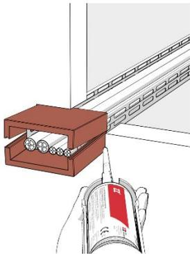
Bauteillaibung von Schmutz, Öl, Wachs und Fett reinigen.
