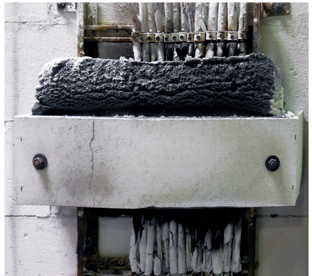
ZZ ® W20 nach der 90-minütigen Brandbeanspruchung nach Einheitstemperaturkurve (ETK)
